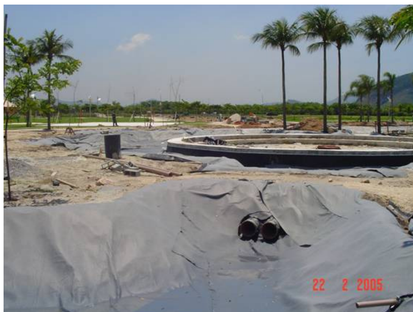
FOTO 2 Instalação do geotêxtil Bidim RT-10 na base do lago.
