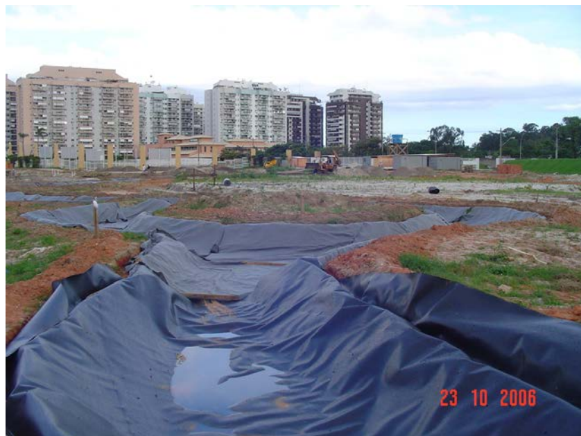
Detalhe da aplicação da geomembrana sobre a Manta Geotêxtil Bidim RT-08.
