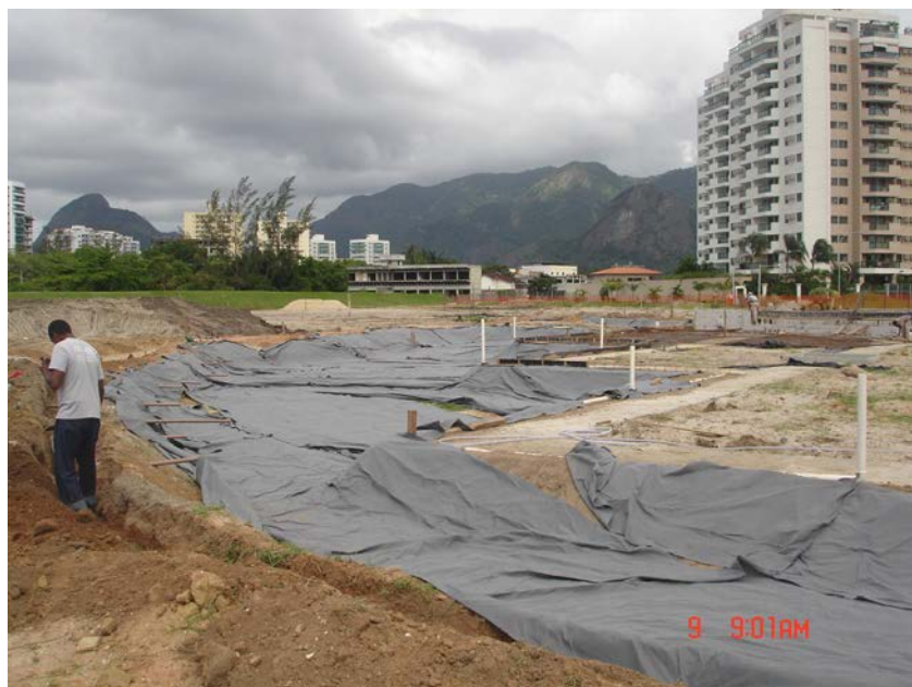
Detalhe da instalação da Manta Geotêxtil Bidim RT-08.
