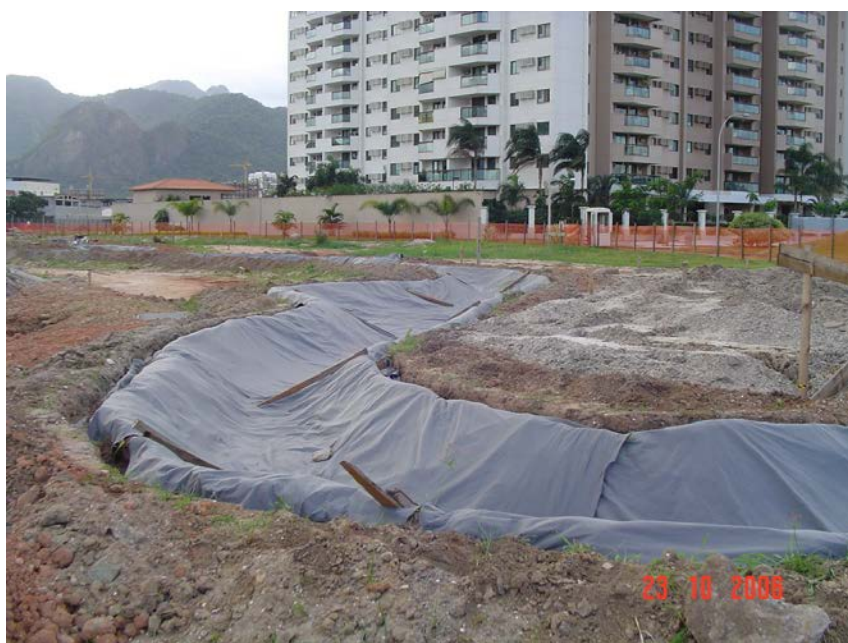
Proteção com Manta Geotêxtil Bidim RT-08 sobre a geomembrana.
