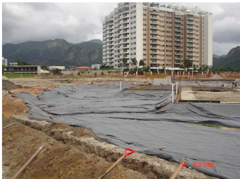
a Instalação da Manta Geotêxtil Bidim RT-08.
