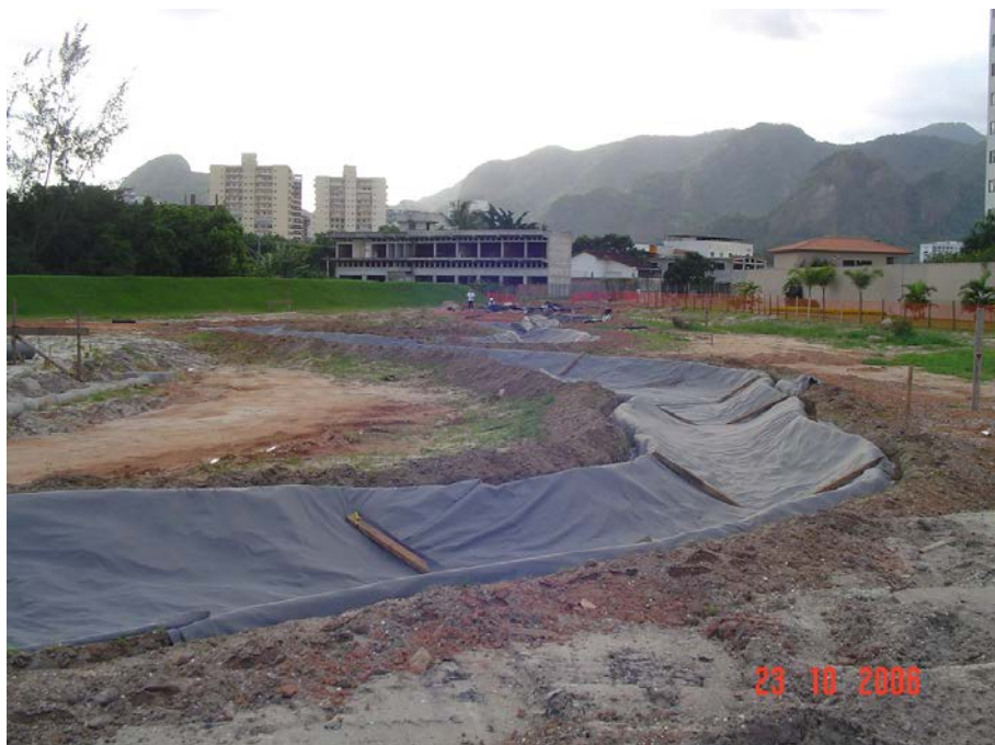
Início da aplicação da Manta Geotêxtil Bidim RT-08na base.
