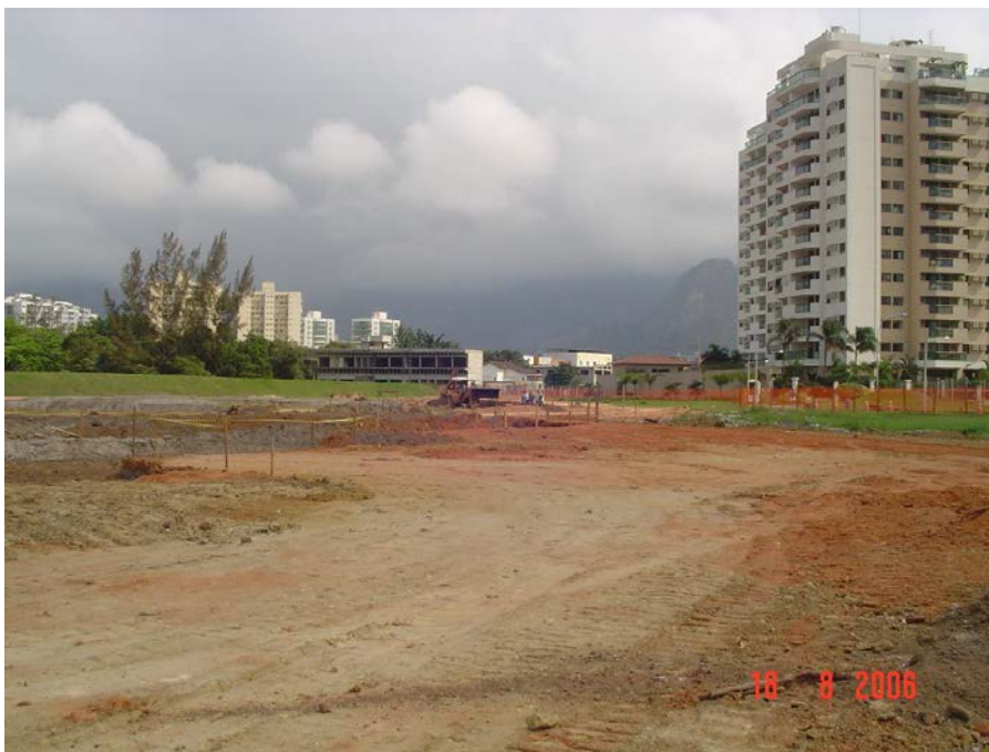
Início dos Serviços de Terraplenagem.
