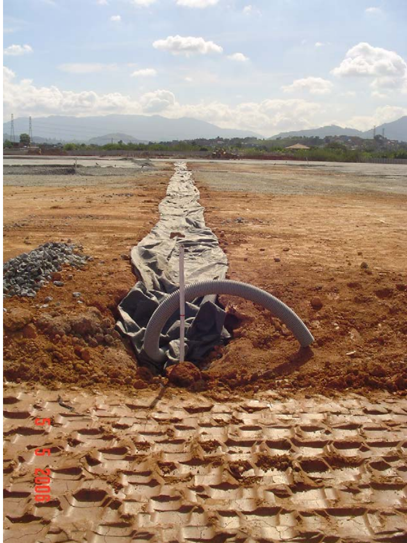
Final da trincheira drenante.
