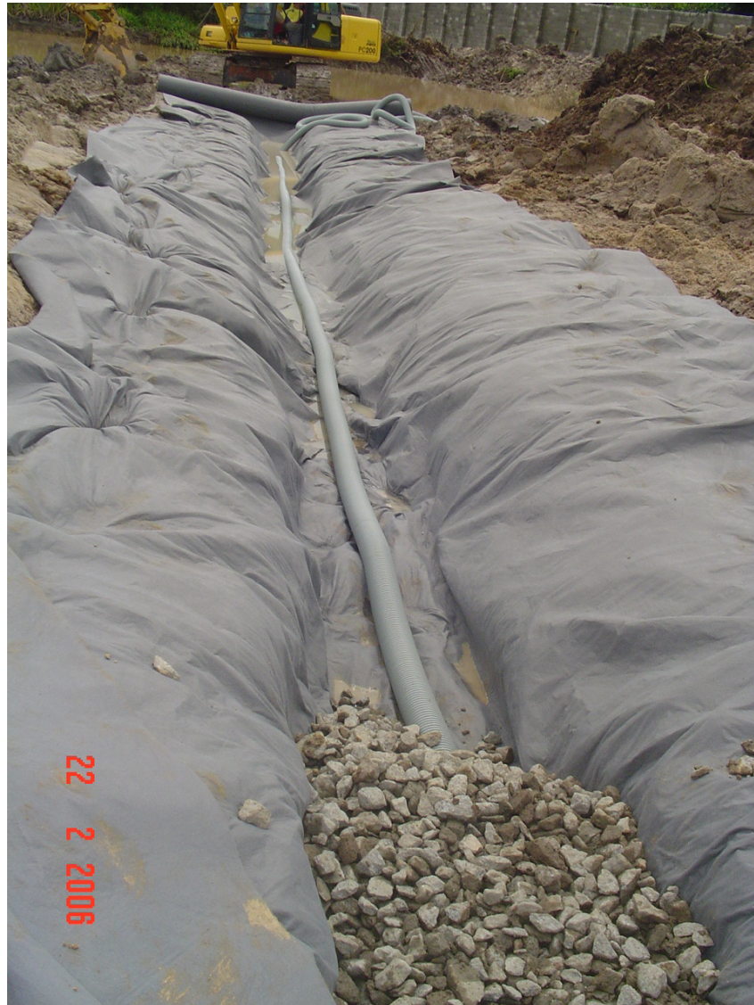
Detalhe da trincheira drenante com Manta Geotêxtil Bidim RT-16
