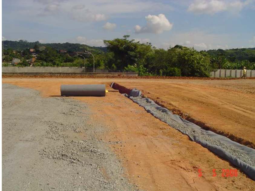
Vista geral da trincheira drenante
