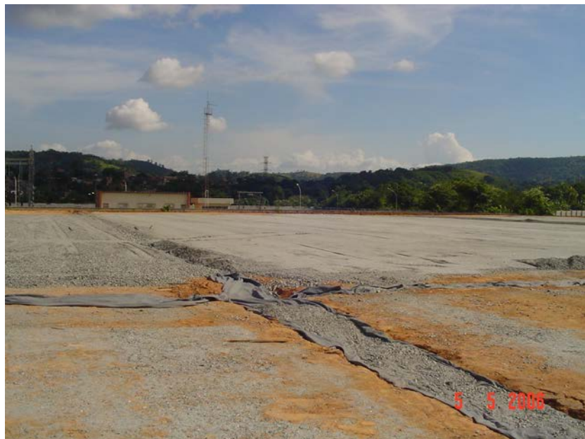
Vista geral da trincheira drenante
