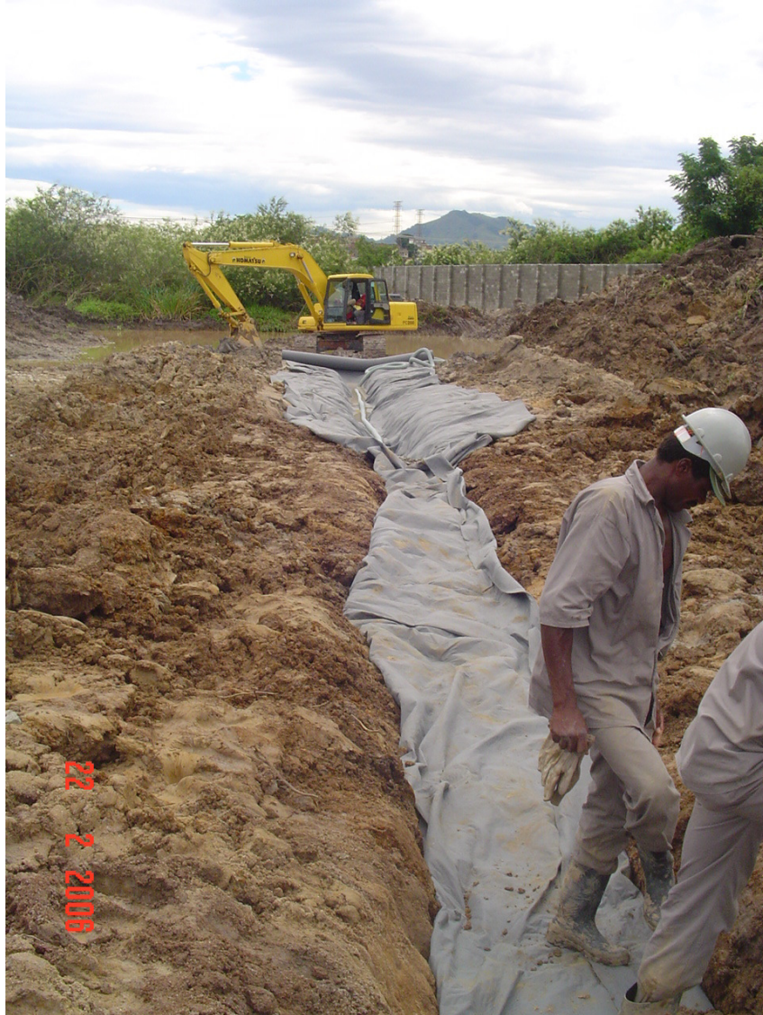
Fechamento da trincheira drenante.
