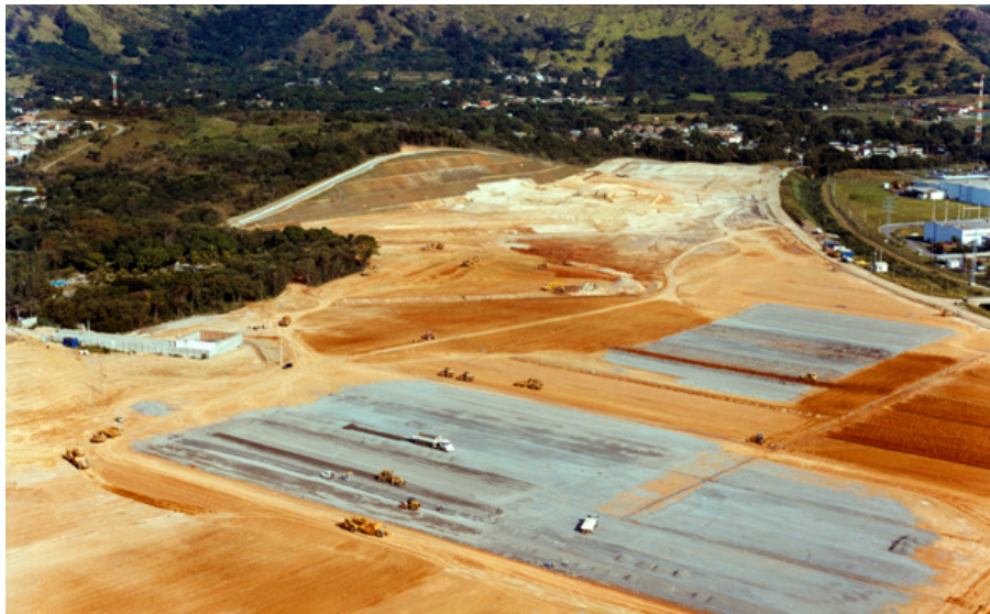
Vista geral da obra.
