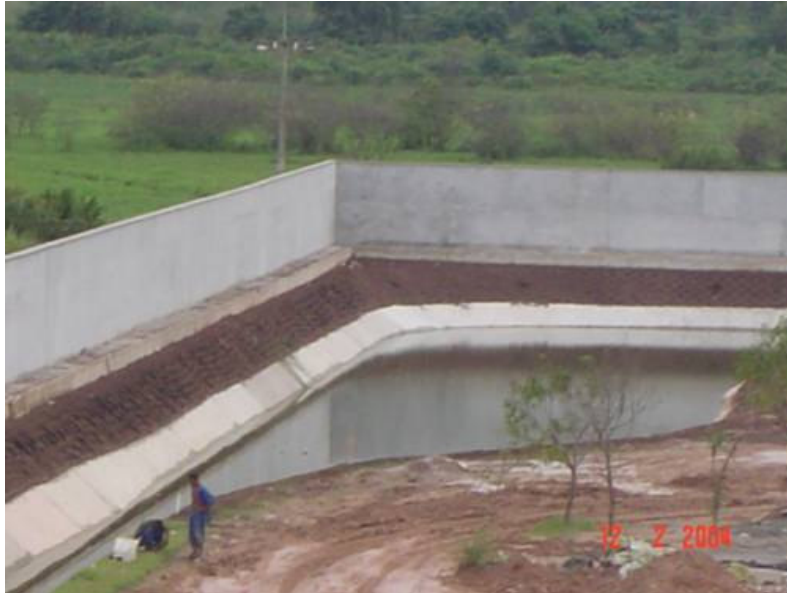
Canal maior já cheio d'água e vegetação em implantação.
