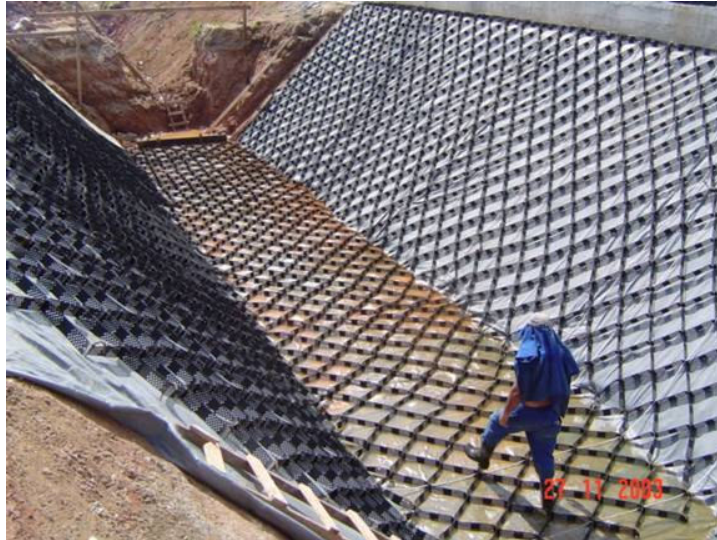
Canal menor em execução.
