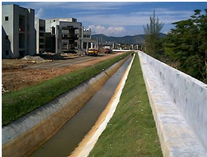
Canal menor concluído.
