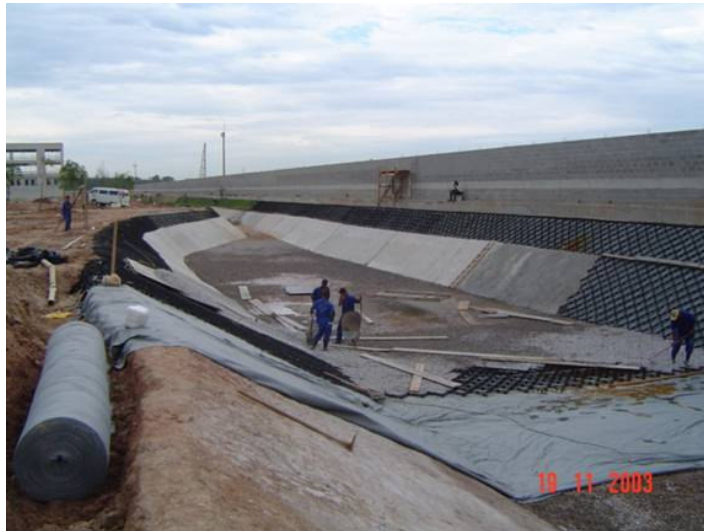
Instalação da Manta Geotêxtil Bidim RT-09 e do Geoweb GW40V3.
