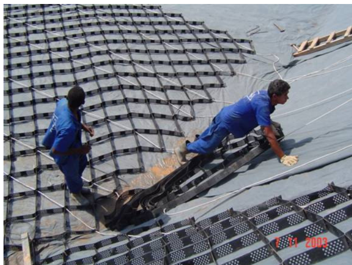
Detalhe da instalação do Geoweb GW40V3 com tirantes.
