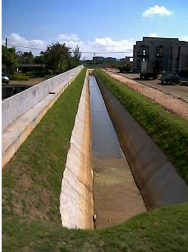
Canal menor concluído.
