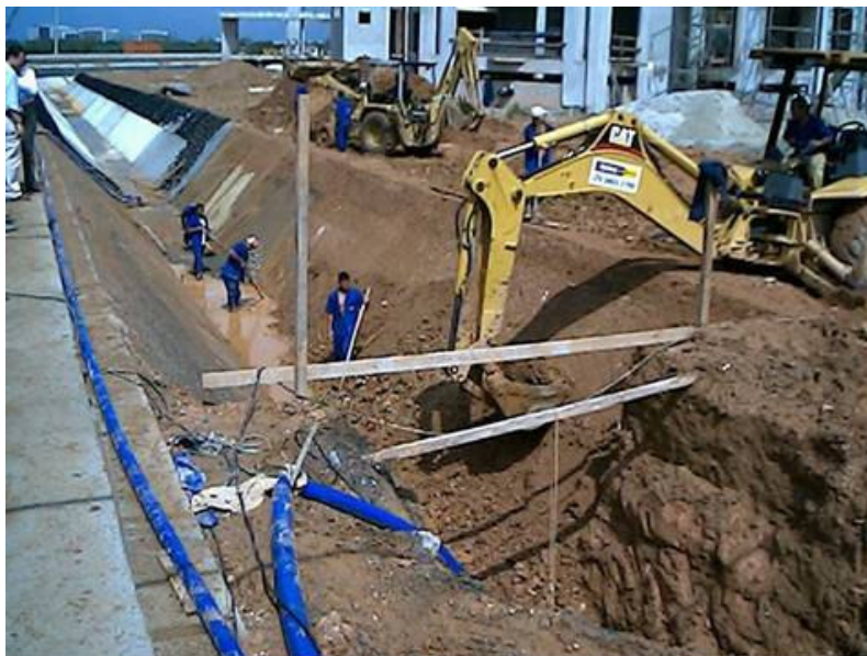
Canal menor em escavação.
