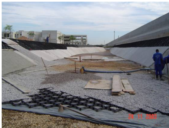
Instalação da Manta Geotêxtil Bidim RT-09 e do Geoweb GW40V3. Fundo do canal maior revestido com brita para evitar problemas de subpressão devido à oscilação do NA do terreno. Notar a bomba submersa para rebaixamento temporário do NA.
