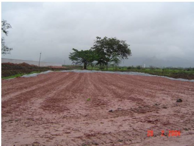
Execução do aterro
