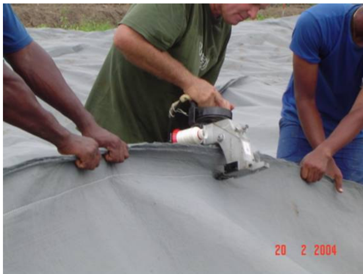
Costura da Manta Geotêxtil Bidim RT-31
