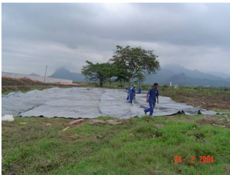
Lançamento da Manta Geotêxtil Bidim RT-31
