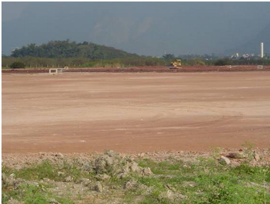
Vista geral da área pronta para receber tráfego de equipamento pesado e início do empreendimento.
