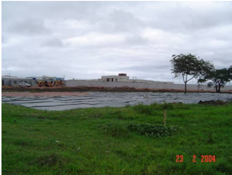
Lançamento da Manta Geotêxtil Bidim RT-31 e execução do aterro
