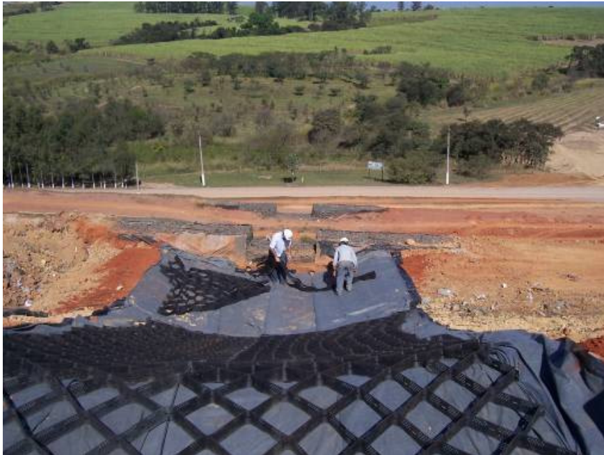
Foto 1- Início da Instalação da Manta Geotêxtil Bidim RT-10 e Geoweb.
