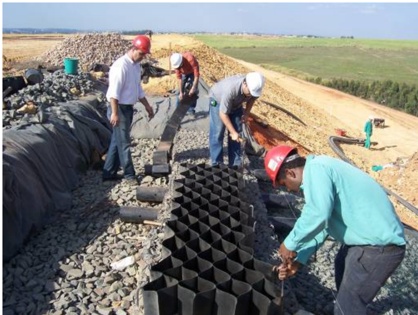
Foto 6 – Início da ombreira com Geoweb GW20V8 .
