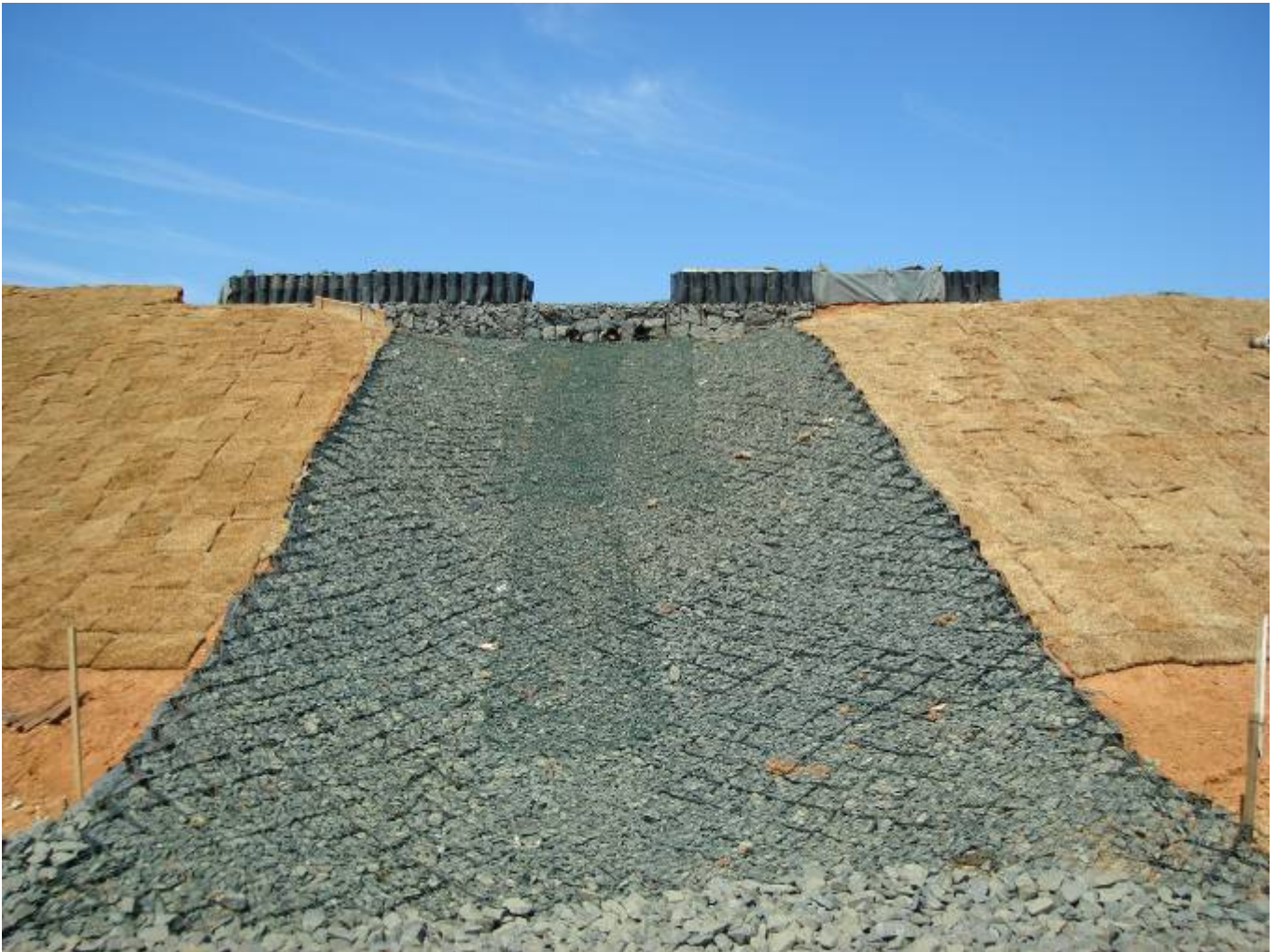
Foto 9 - Vista da descida finalizada.
