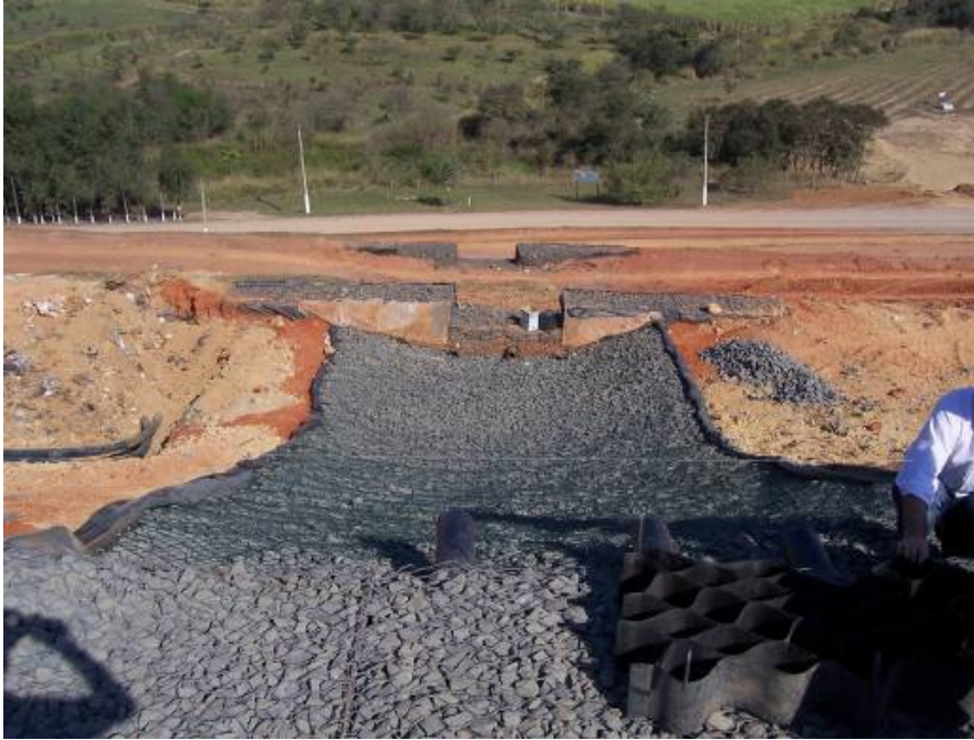
Foto 7 - Vista da descida, já com a tela metálica sobre a Geoweb.
