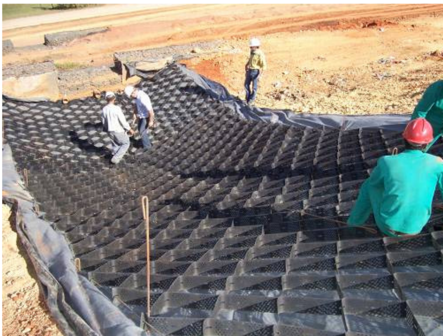
Foto 2- Manta Geotêxtil Bidim RT-10 e Geoweb pronto para enchimento.
