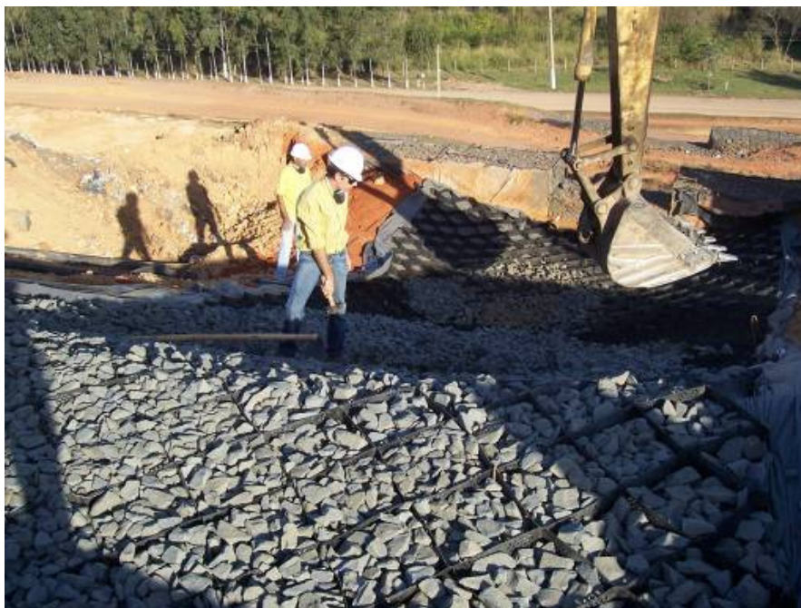
Foto 4 – Prenchimento com brita 4, quase finalizado.
