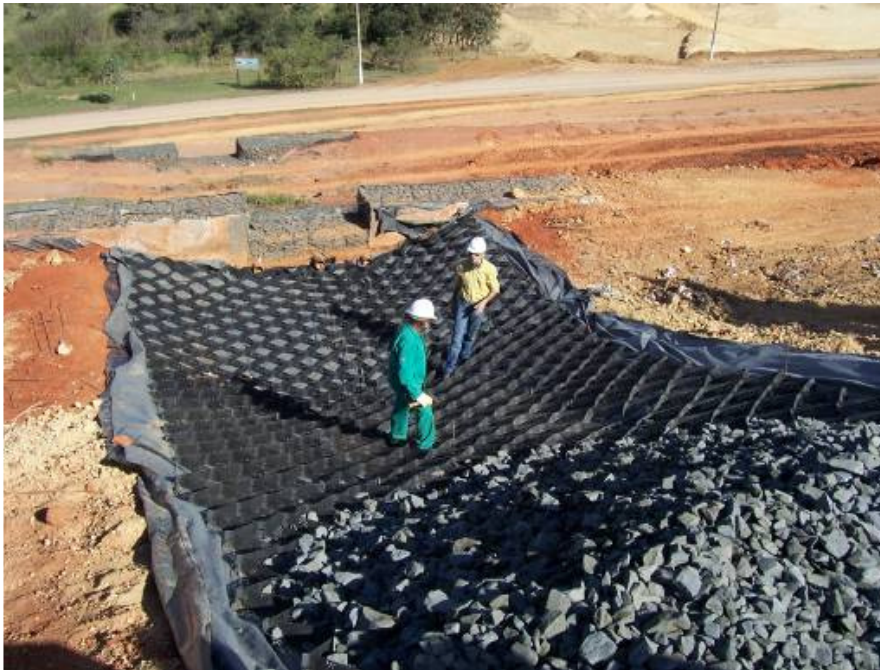
Foto 3 – Início do preenchimento com brita 4.
