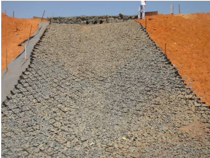
Foto 5 – Preenchimento com brita 4, finalizado.
