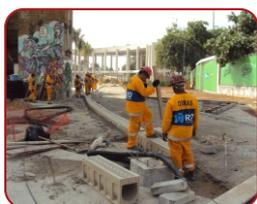
Sistema de drenagem superficial ACO DRAIN para drenagem urbana, industrial e residencial. Fabricado em Concreto Polímero, material composto de resinas e agregados, apresenta maior resistência com menor peso do que o concreto normal.
