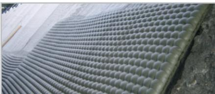
**Incomat® Standard** – Seção transversal contínua para proteção contra erosão de taludes e leitos de canais, rios e portos. A espessura homogênea de concreto, garante certa estanqueidade ao revestimento, mesmo diante de elevadas cargas hidráulicas.
