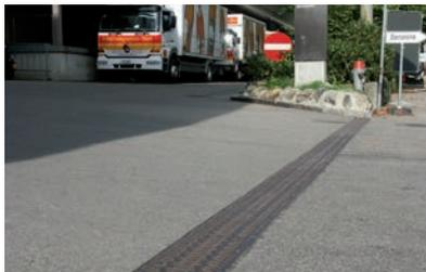
1. A Linha SK da ACO é do tipo M e está projetada para resistir à cargas mais pesadas assim como a tráfegos mais intenso e proteger as águas subterrâneas através da drenagem de líquidos contaminantes, incorporando numerosas inovações técnicas junto a experiência e conhecimentos adquiridos pela ACO em sistemas de drenagem linear.
